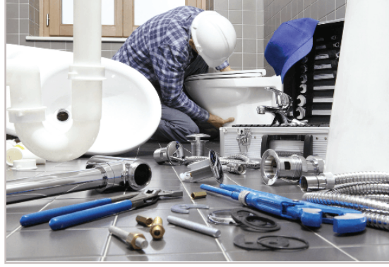
Görsel 3.44: Sıhhi tesisatta çalışma
